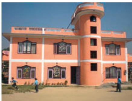
L'ÉCOLE APRÈS RÉNOVATION
